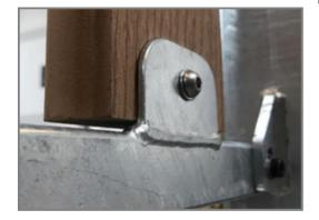
Древесно-пластиковые композитные панели крепятся к сварным фланцам размером 70 х 45 х 3 мм с помощью болтов М8 из нержавеющей стали, гаек и шайб. Эти соединения не видны изнутри и создают прочное и безопасное соединение.
